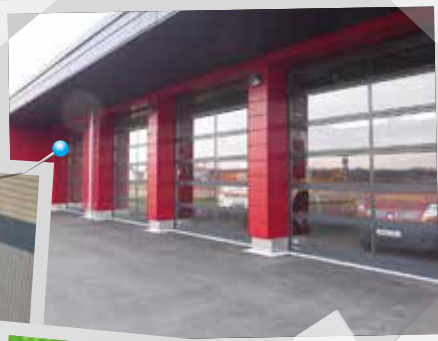
Neues FFW- Haus Rain
