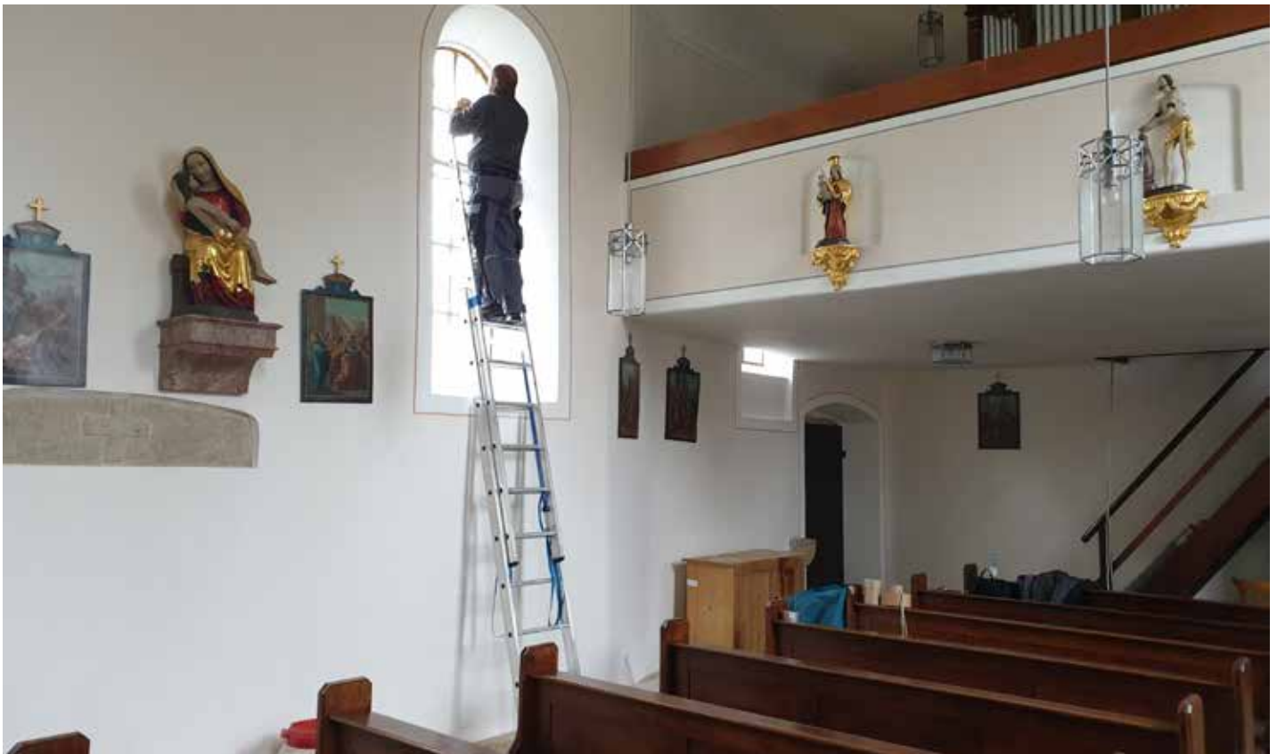
Mitarbeiter der Fa. Binker beim Abdichten der Fenster (Bild: Martin Werdin)
