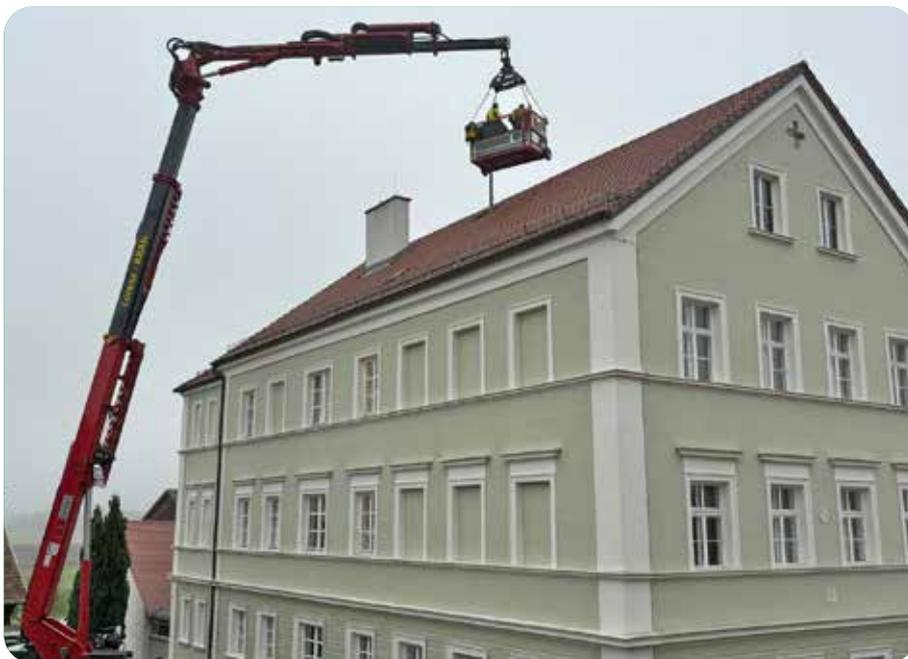
Seit dem 16. November ertönt zur gewohnten Probealarmzeit um 11 Uhr eine neue Sirene in Atting, die zuvor mittels Kran auf dem Dach des Bürgerhauses Alte Schule installiert wurde. Der Austausch war erforderlich, weil die alte Warnanlage defekt war und keine Ersatzteile mehr beschafft werden konnten. Die neue Sirene ist mit Druckkammerlautsprechern ausgestattet. „Der Ton ist etwas lauter und greller als unsere Bürger das bisher gewohnt waren“, sagt Bürgermeister Robert Ruber.
