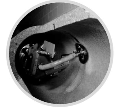
Schnitt durch ein Rohr während einer Robotersanierung
