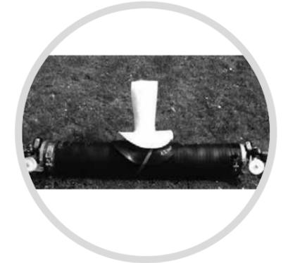
Vorbereitung für den Einbau; da „Hütchen“ wird auf dem Packer befestigt
